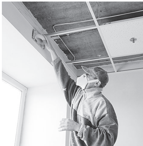
Рис. 9.27. Зашкуривание шпатлевки
