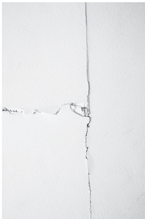
Рис. 10.2. Трещины на гипсокартоне
