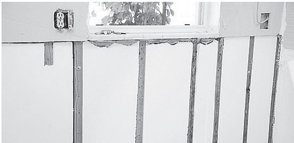
Рис. 4.26. Деревянный каркас с плитами пенопласта
