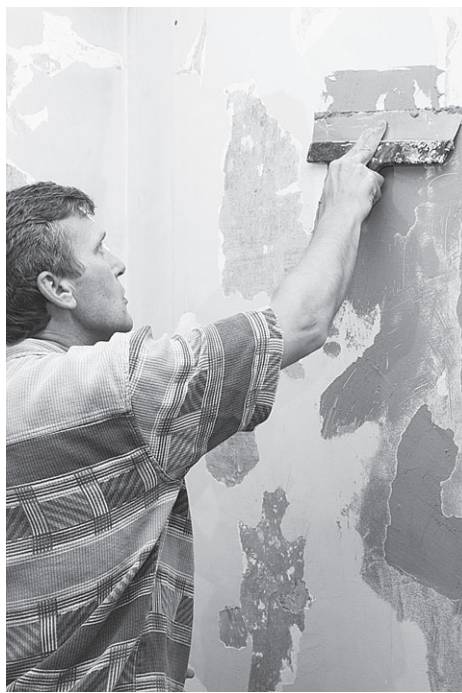
Рис. 4.5. Выравнивание стены штукатуркой
