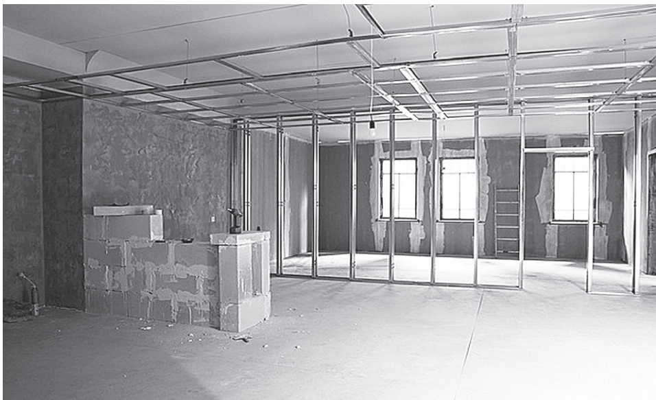
Рис. 5.5. Металлический каркас потолка и перегородки
