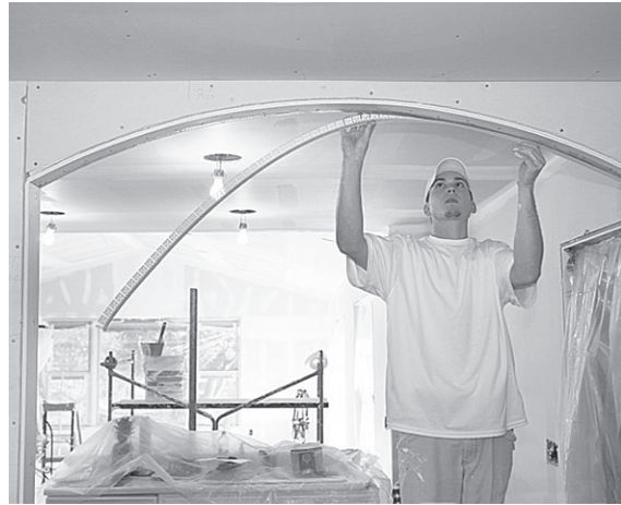
Рис. 8.2. Монтаж арки
