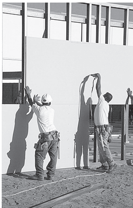
Рис. 4.39. Монтаж листов гипсокартона на перегородку
