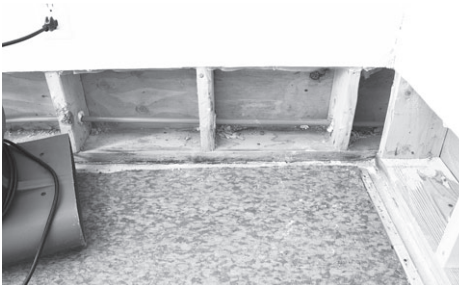
Рис. 4.34. Обшивка деревянного каркаса листом
