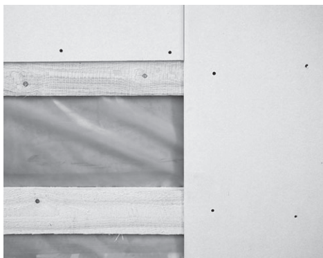
Рис. 4.21. Обшивка листами деревянного каркаса
