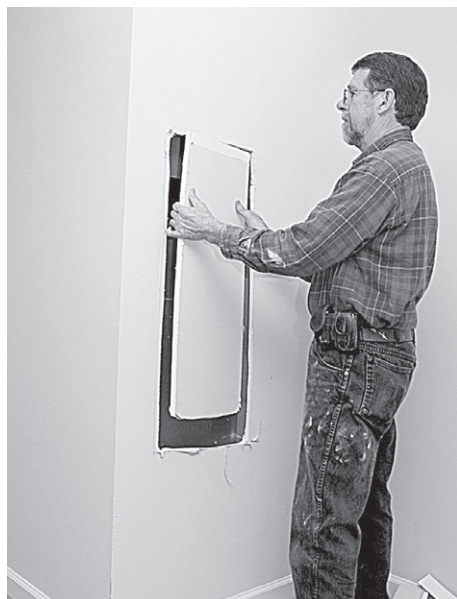
Рис. 8.12. Выпиленный кусок вынимается из стены
