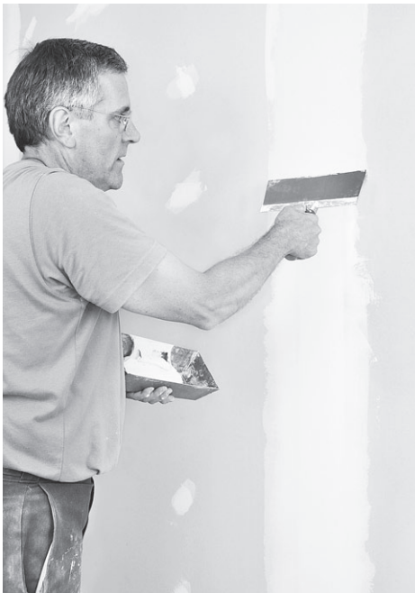
Рис. 9.14. Заделка швов
