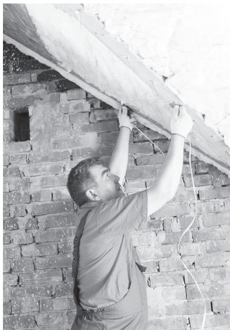
Рис. 6.9. Монтаж утеплителя на потолок
