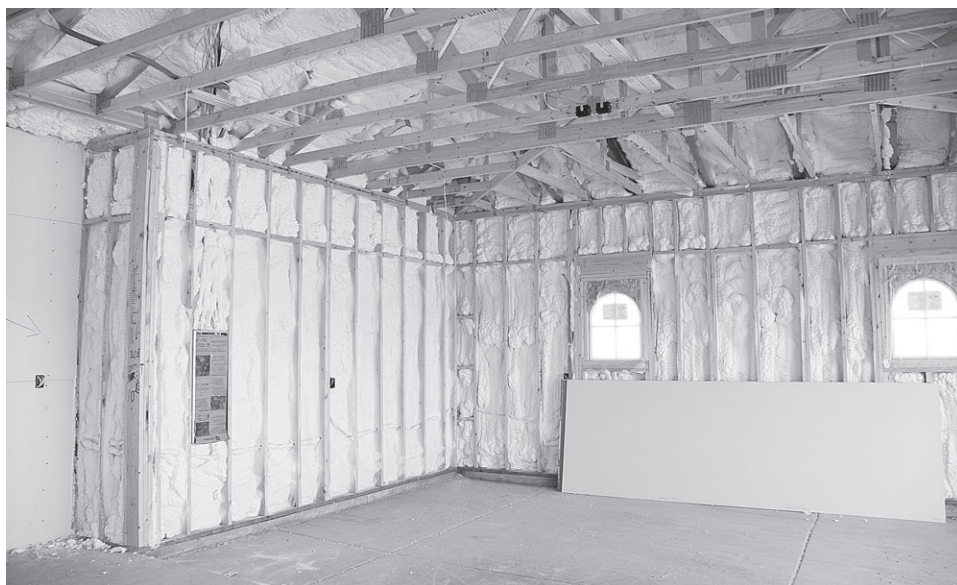
Рис. 4.17. Готовый деревянный облицовочный каркас
