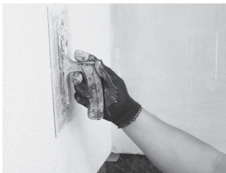
Рис. 9.21. Шпаклевка стены
