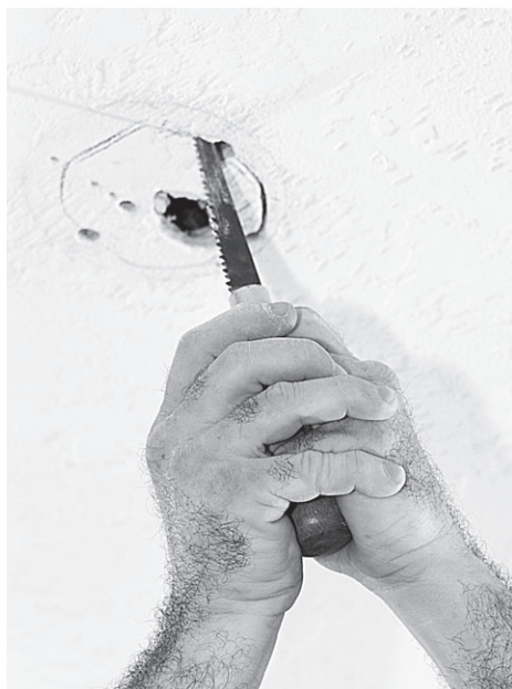
Рис. 9.11. Выпиливание отверстия под светильник в гипсокартонном потолке
