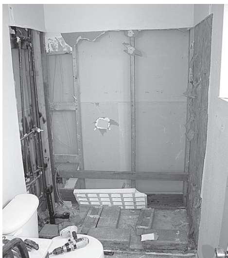
Рис. 4.24. Деревянный каркас в ванной комнате
