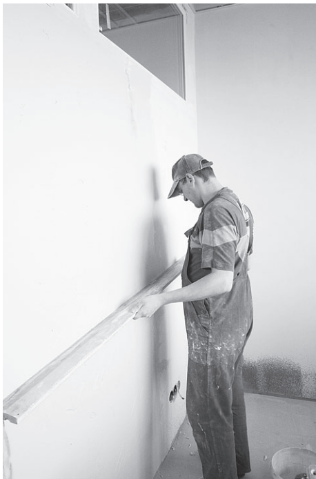
Рис. 3.12. Проверка плоскости стены прави́лом
