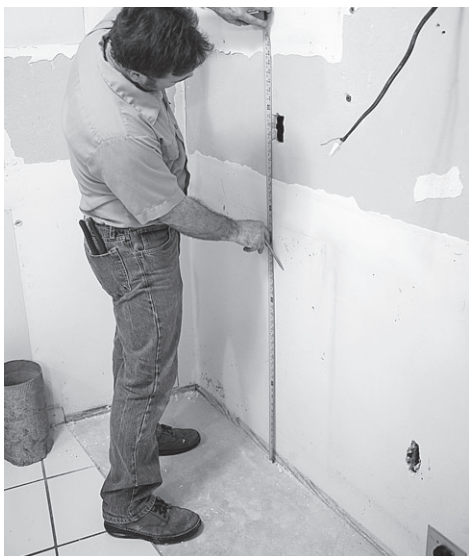
Рис. 9.4. Замер электрической точки
