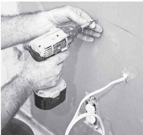
Рис. 4.33. Положение рук при закручивании крепежа
