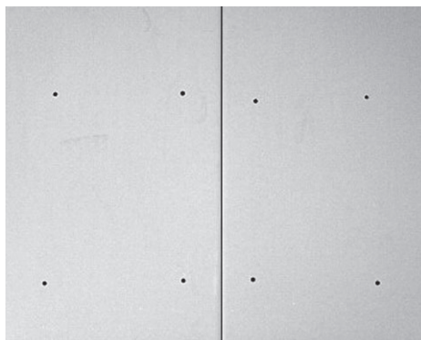
Рис. 4.22. Стык гипсокартонных листов с крепежом
