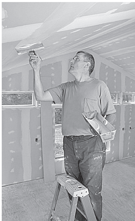
Рис. 9.15. Заделка потолочных швов
