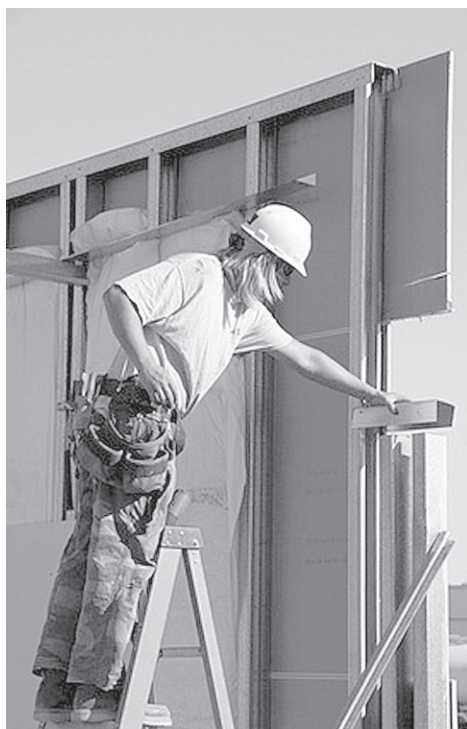
Рис. 4.38. Монтаж гипсокартонной перегородки
