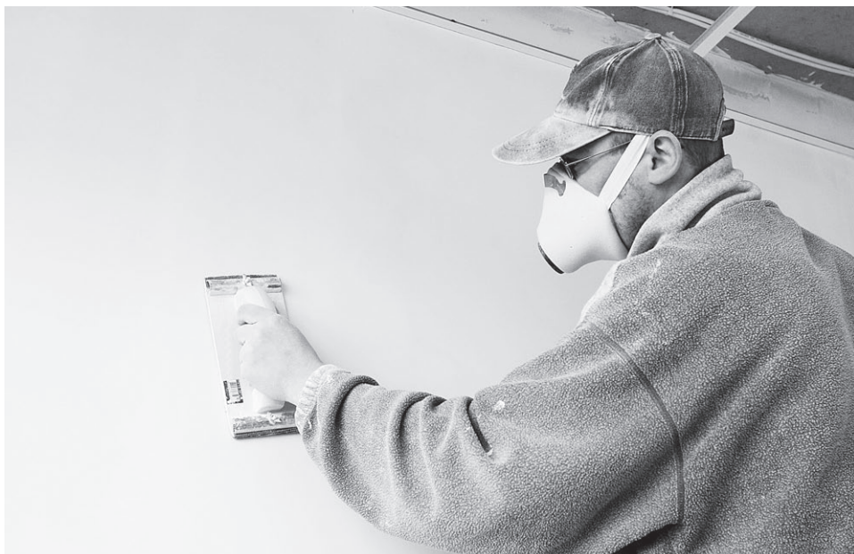
Рис. 9.25. Зашкуривание шпатлевки
