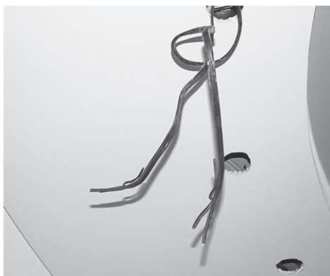
Рис. 9.3. Потолок с вырезанными отверстиями под светильники
