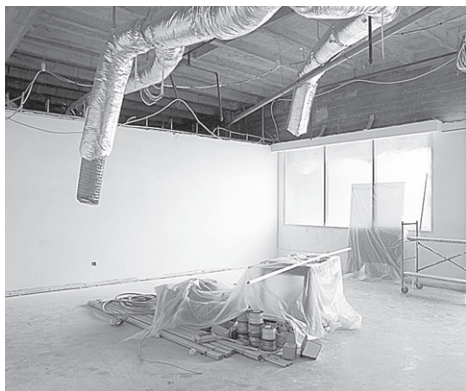
Рис. 9.2. Вентиляционные трубы
