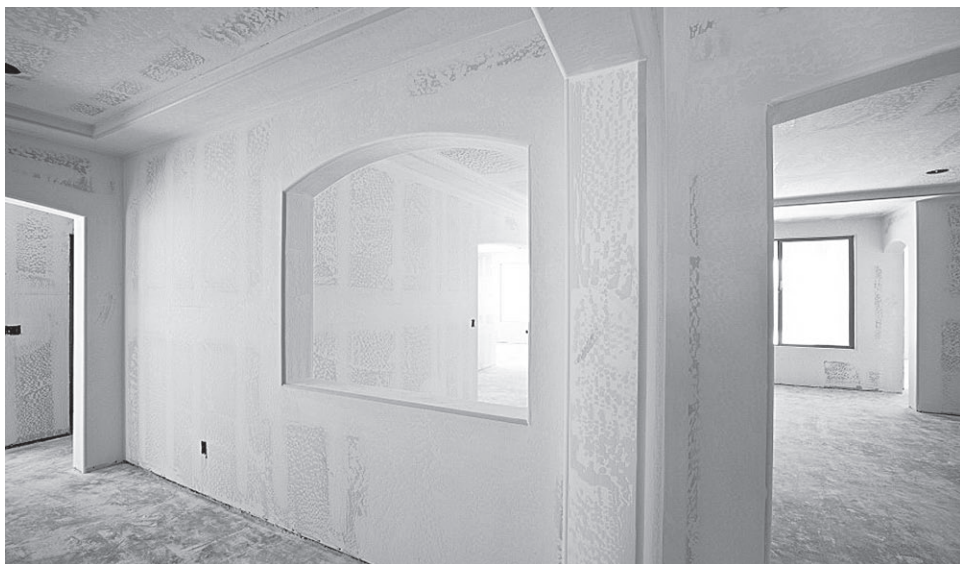
Рис. 5.14. Вариант перегородки со сквозным отверстием
