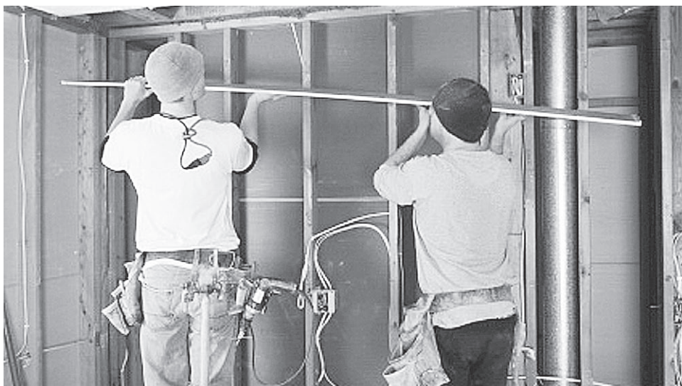
Рис. 4.18. Монтаж перегородки на деревянном каркасе
