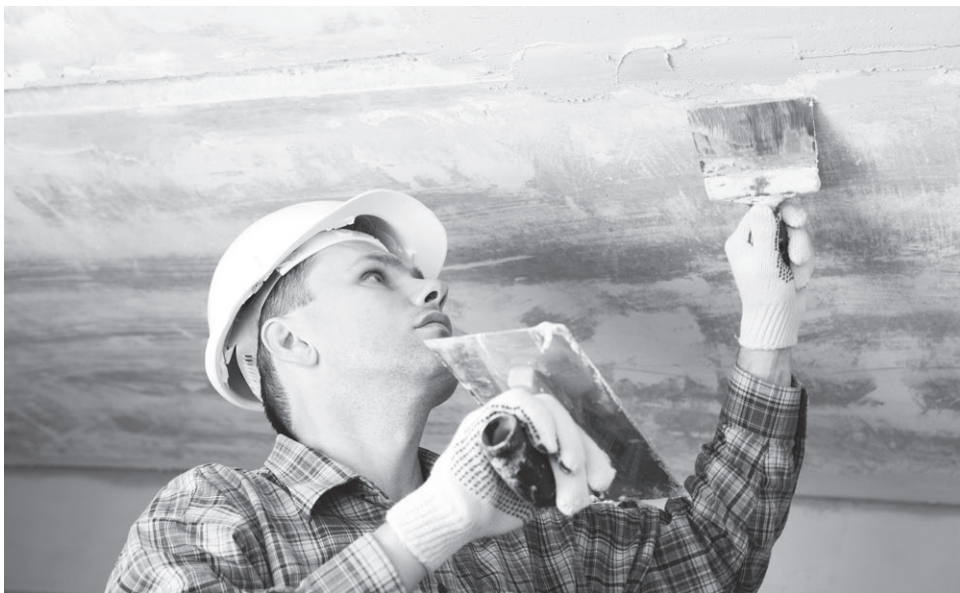
Рис. 6.3. Выравнивание смеси при помощи шпателя
