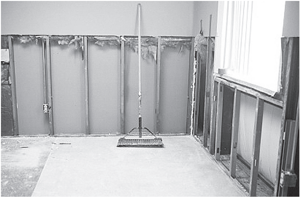
Рис. 4.41. Металлический каркас
