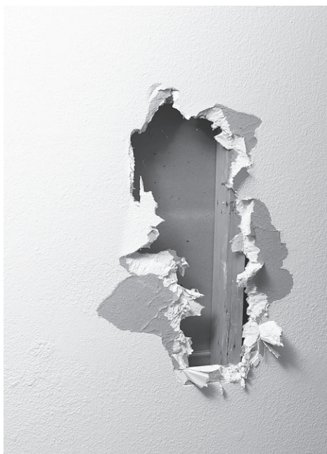
Рис. 10.4. Механическое повреждение
