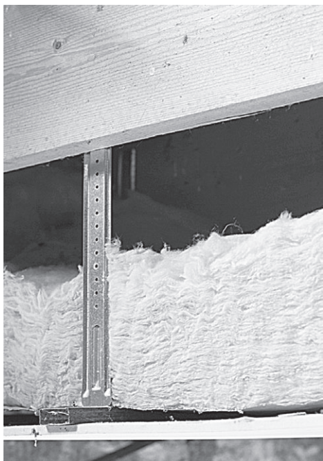
Рис. 6.8. Минеральная вата в межпотолочном пространстве
