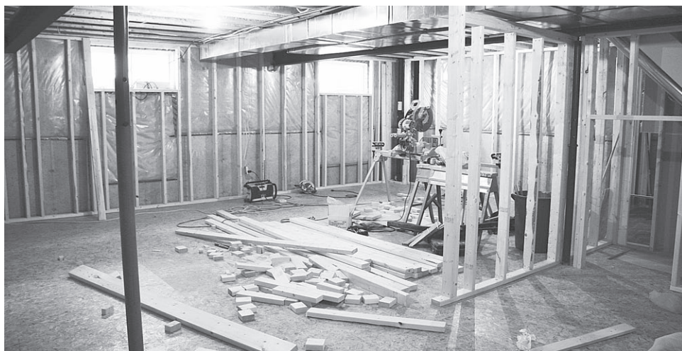
Рис. 4.23. Облицовочный и перегородочный деревянные каркасы
