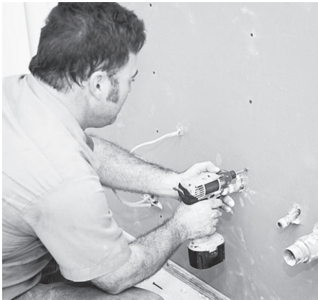
Рис. 4.32. Закручивание шурупов при помощи аккумуляторной дрели
