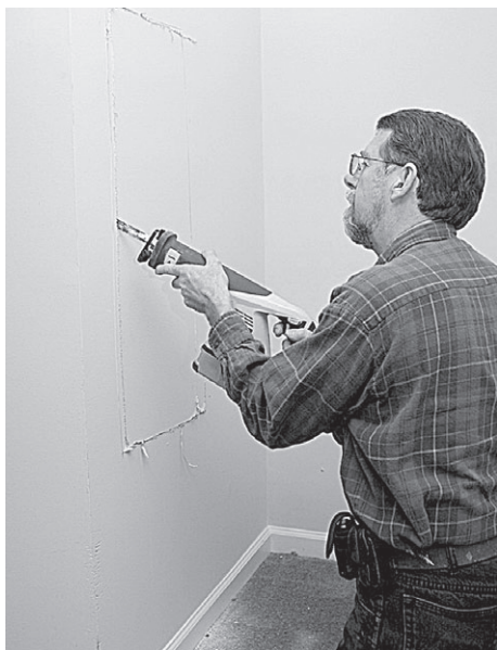
Рис. 8.11. Вырезание границы ниши
