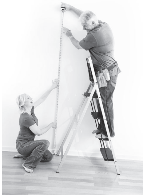
Рис. 3.19. Измерение высоты стены рулеткой
