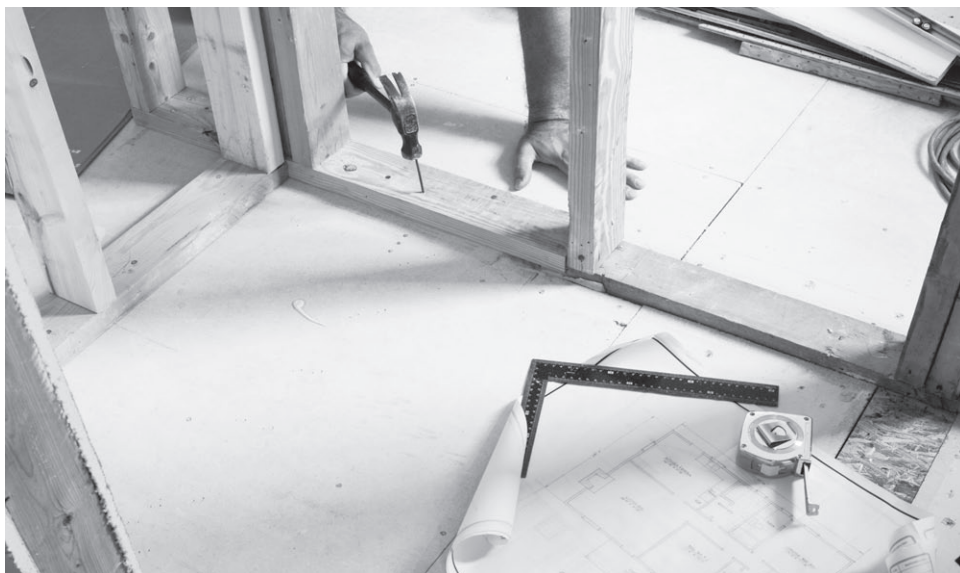
Рис. 5.3. Крепление бруса обвязки
