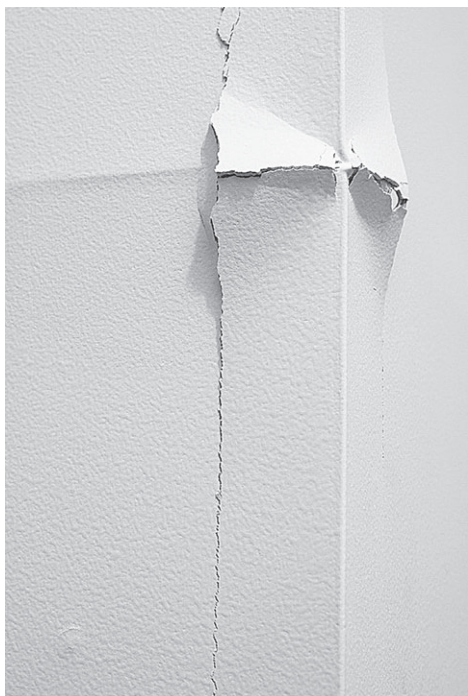
Рис. 10.1. Отслоившийся гипсокартон
