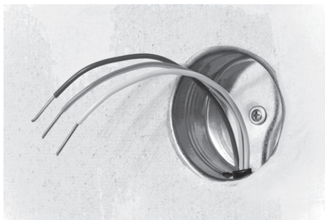
Рис. 9.6. Подрозетник металлический по бетону
