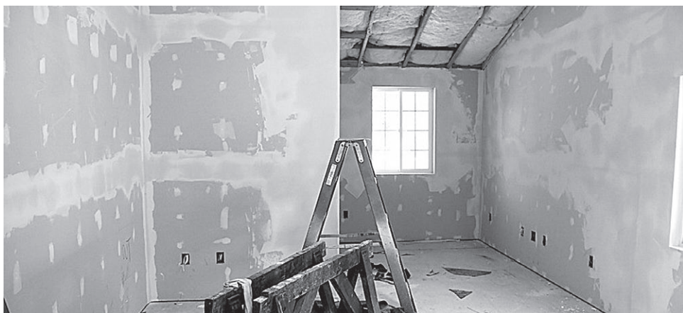
Рис. 4.30. Готовая облицовка стен с потолочным каркасом
