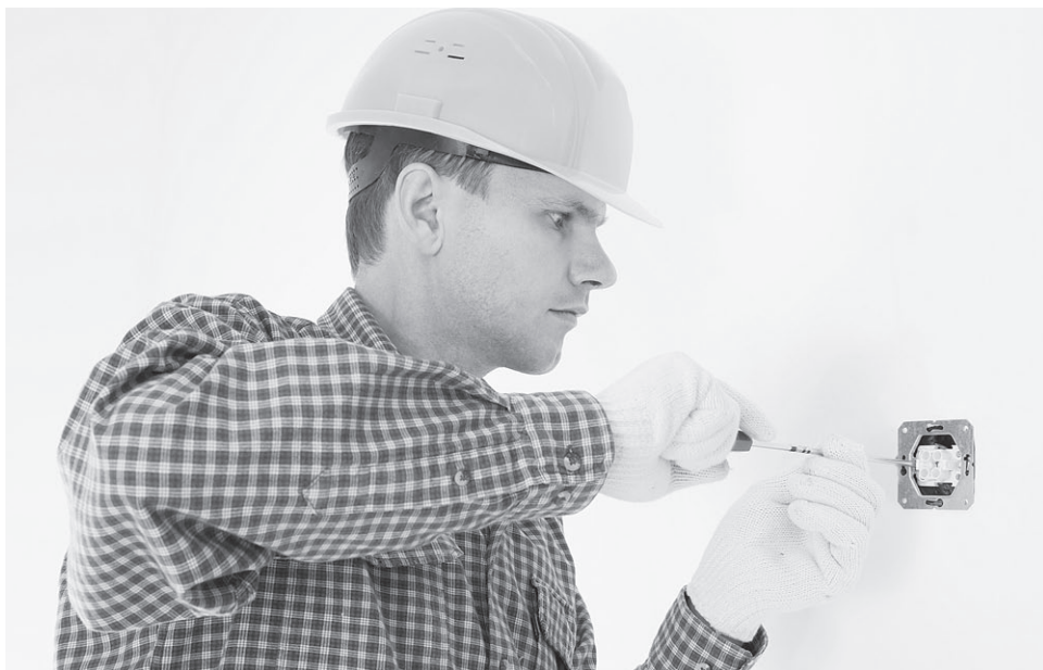
Рис. 9.10. Закрепление колодки на гипсокартоне
