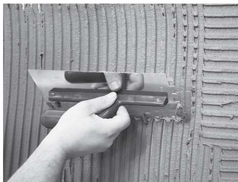
Рис. 3.9. Шпатель гипсокартонный с зубцами (американка)
