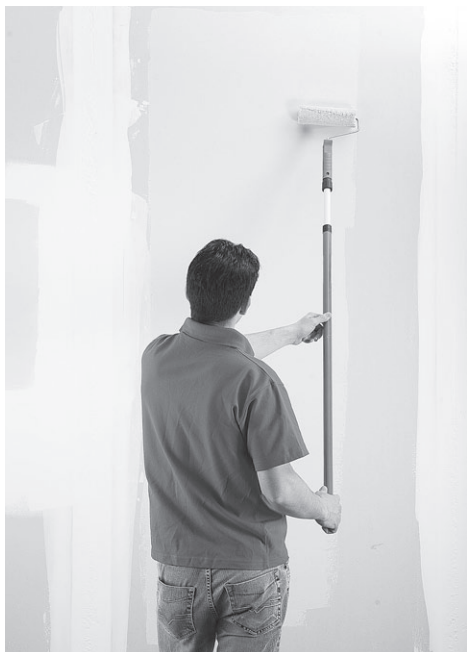
Рис. 9.30. Окраска гипсокартона валиком
