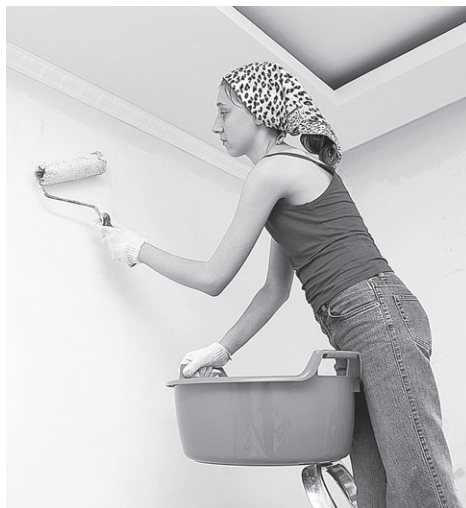
Рис. 6.4. Грунтование поверхности при помощи валика
