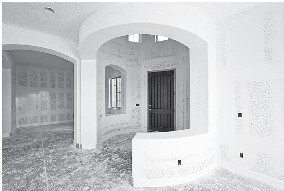
Рис. 8.21. Криволинейная неполная перегородка
