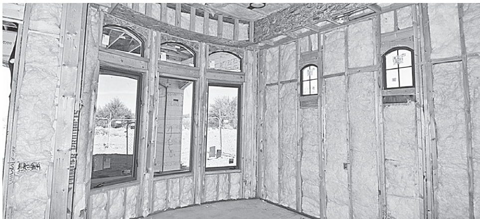
Рис. 4.29. Готовый деревянный каркас с изоляцией из минеральной ваты
