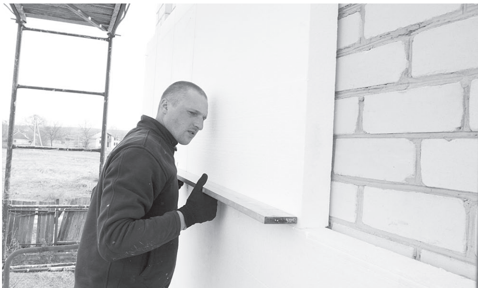
Рис. 2.23. Утепление поверхности плитами пенопласта
