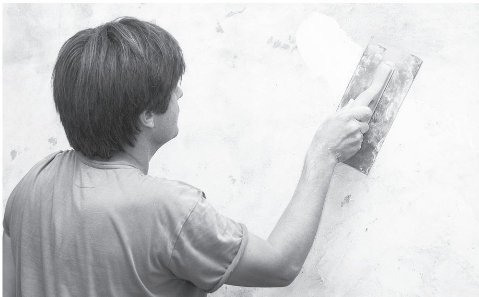
Рис. 4.4. Финальное выравнивание стены
