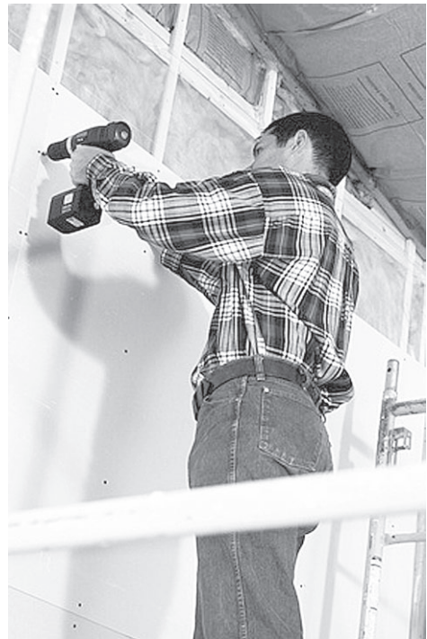
Рис. 4.35. Крепление листов гипсокартона к деревянному каркасу
