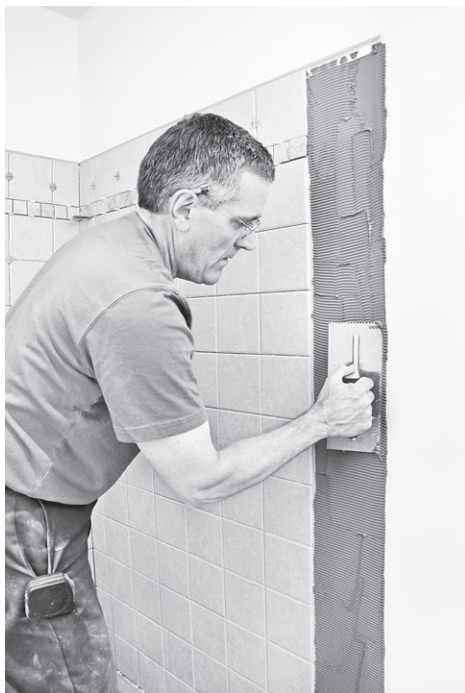
Рис. 9.35. Кладка плитки на гипсокартон
