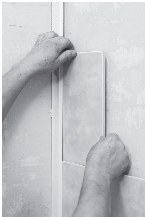
Рис. 9.36. Кладка угловых плиток
