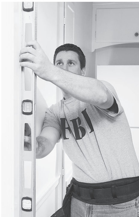
Рис. 3.17. Измерение вертикали стены при помощи уровня
