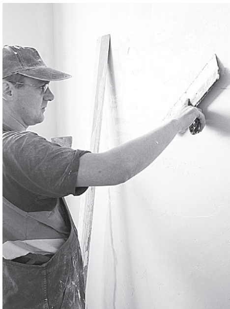
Рис. 9.23. Шпаклевание гипсокартона
