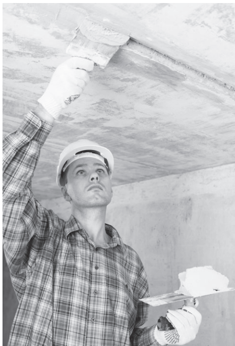
Рис. 6.2. Заделка щелей между потолочными плитами смесью
