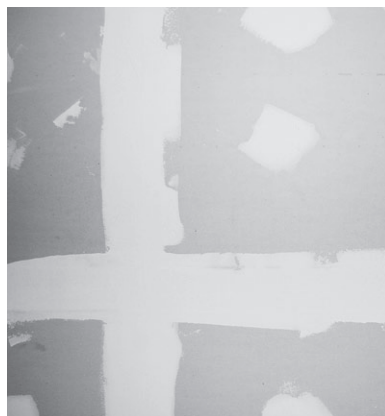
Рис. 9.17. Гипсокартон с заделанными швами
