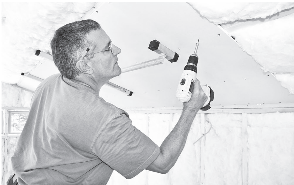
Рис. 6.5. Обшивка потолочного каркаса гипсокартоном
