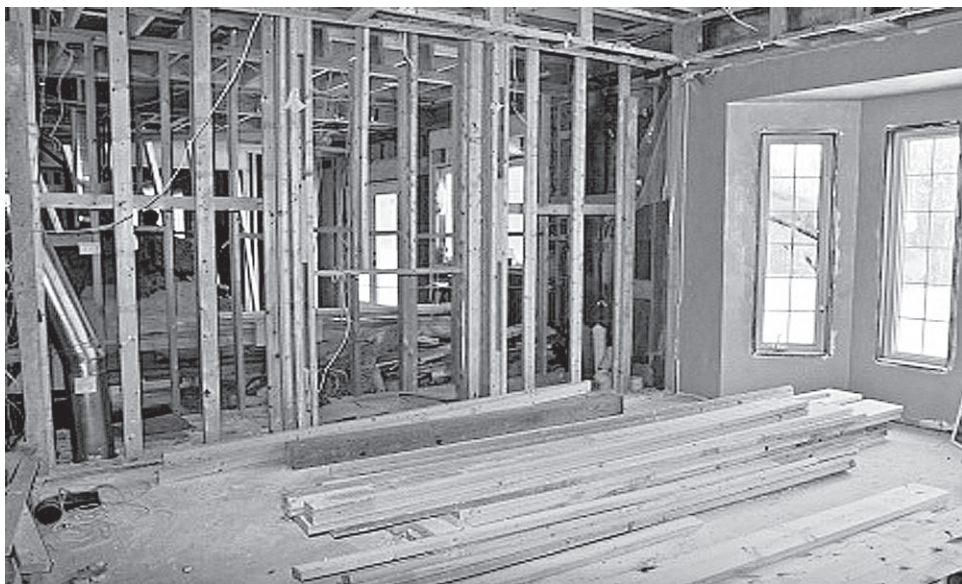
Рис. 5.4. Вариант перегородки на деревянном каркасе
