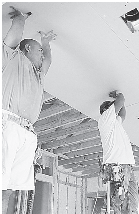
Рис. 6.7. Монтаж листа к потолку
