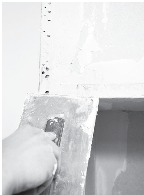
Рис. 9.24. Шпаклевка углов
