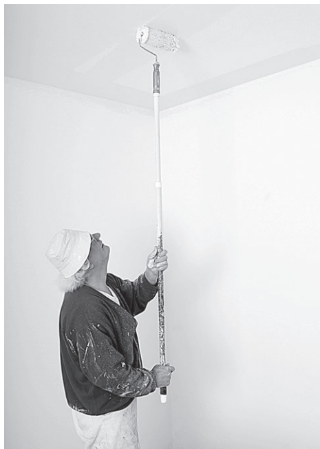
Рис. 9.31. Окраска потолка валиком на ручке
