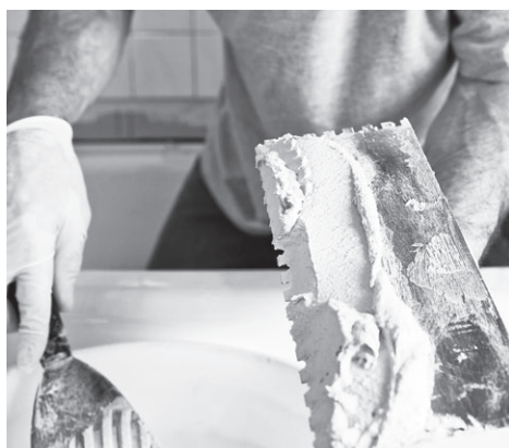
Рис. 9.22. Набор шпатлевки на «американку»
