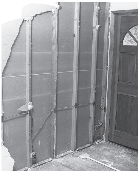
Рис. 4.19. Каркас облицовки в прихожей
