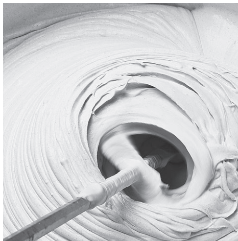
Рис. 9.18. Замешивание шпатлевки при помощи миксера
