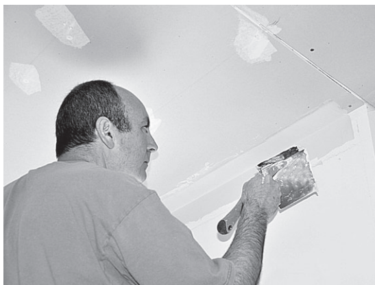
Рис. 9.16. Заделывание внутреннего угла
