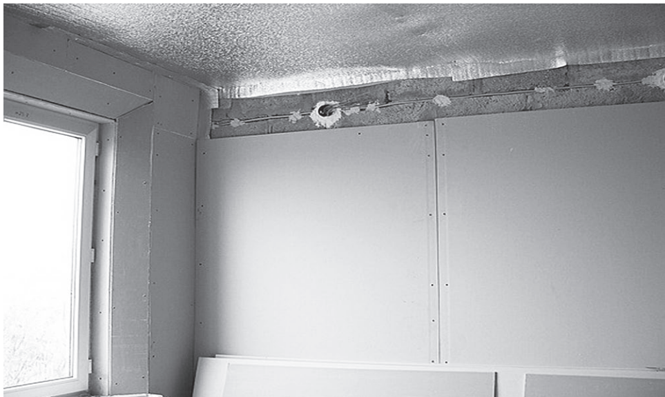
Рис. 6.12. Потолок, покрытый термоизоляционной пленкой
