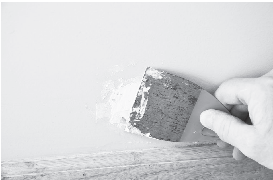
Рис. 10.3. Замазывание дефекта шпателем
