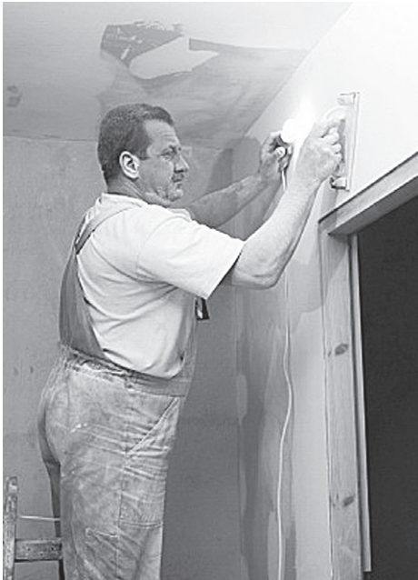
Рис. 9.28. Зашкуривание поверхности с лампой
