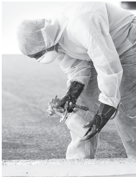
Рис. 9.33. Окраска при помощи распылителя
