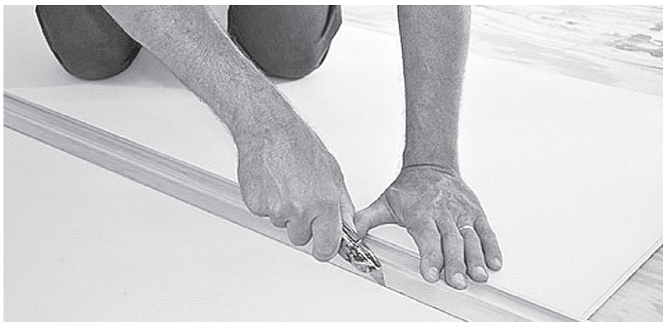
Рис. 4.9. Резка гипсокартона
