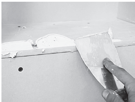
Рис. 9.20. Для заделки углов и сложных поверхностей удобнее использовать небольшой шпатель
