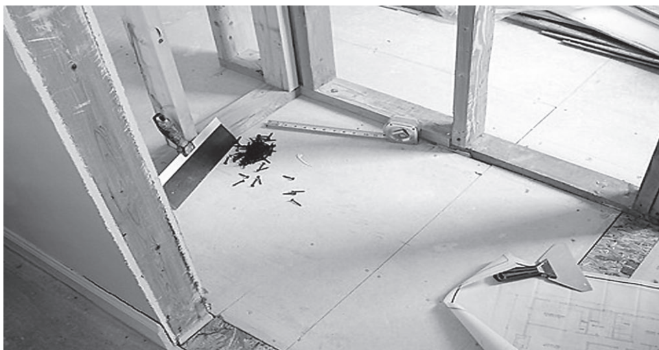
Рис. 5.2. Монтаж каркаса
