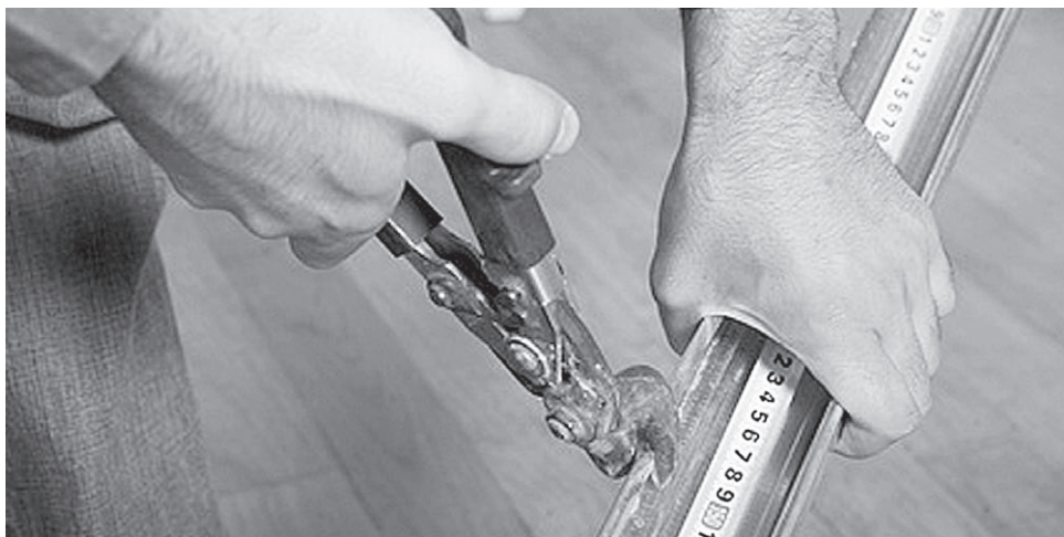
Рис. 3.8. Обрезка профиля при помощи ножниц по металлу
