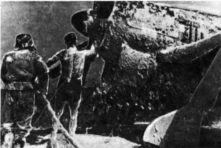
Тушение пожара силовой установки BMW801 на первых FW190 с помощью пеногасителя
