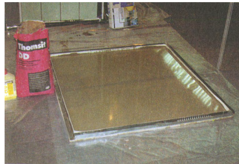
Самовыравнивающиеся системы (СВ-смеси) создают ровную, гладкую и прочную поверхность
