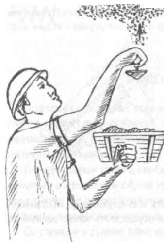
Нанесение раствора снизу вверх
