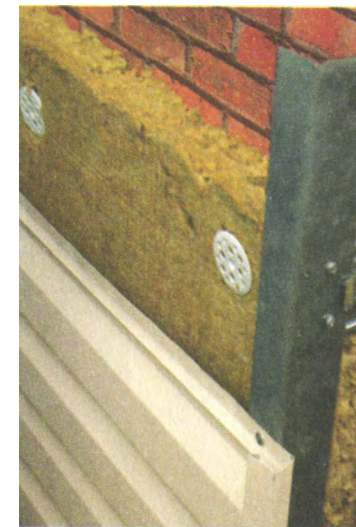
Пространство между облицовкой из сайдинга и стеной, как правило, заполняется теплоизоляционным материалом
