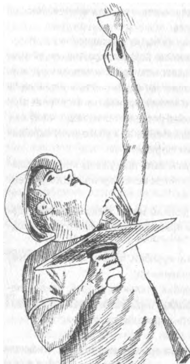
Заполнение трещин алебастровым раствором
