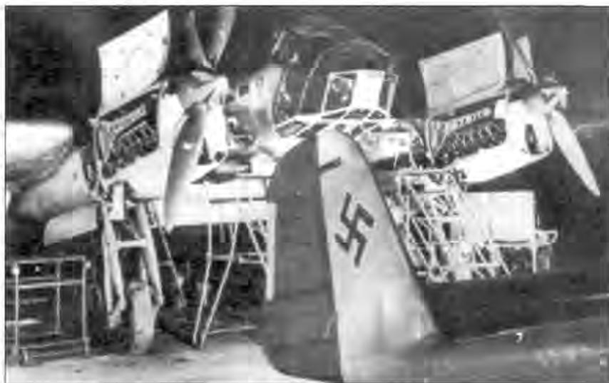
*Окончательная сборка разведчика Fw-189A-1 (W.Nr. 0032) на заводе фирмы Фокке-Вульф в Бремене. Капоты двигателей Аргус As-410 откиннуты для проверки моторов. От Fw-189V-4 серийные самолеты отличались основными опорами шасси рамной конструкции.*
