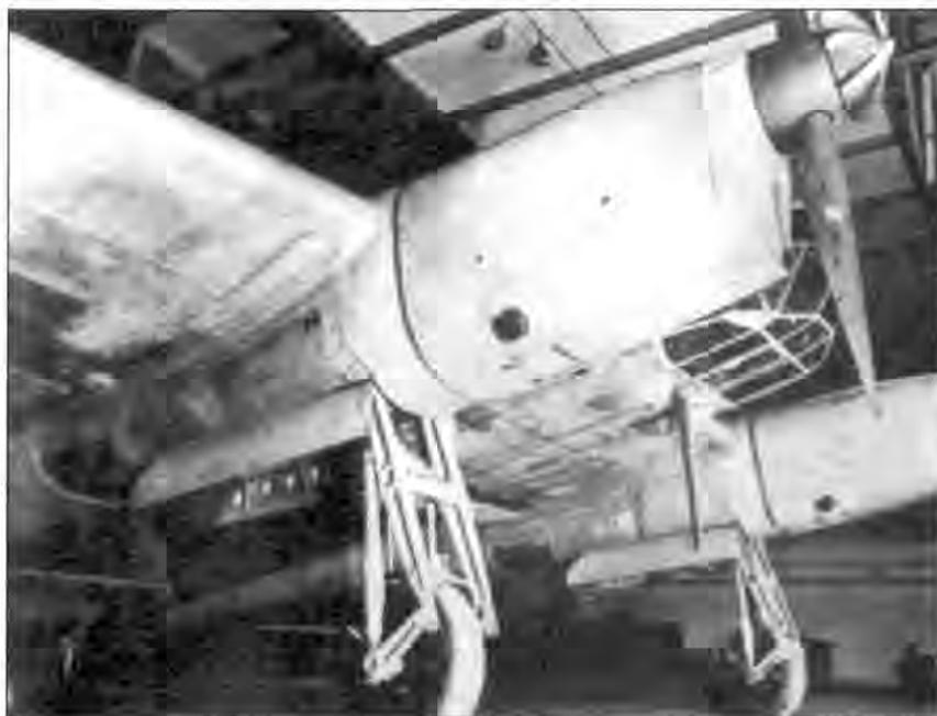
*12-цилиндровый двигатель Аргус Аs-410 комплектовался двухлопастным деревянным винтом изменяемого шага. Обратите внимание на рамные основные опоры шасси серийного самолета Fw-189A.*
