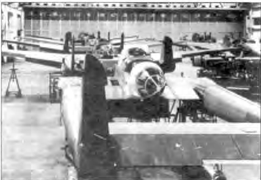
*Сборочная линия разведчиков Fw-189A, у самолета на переднем плане внешние части крыла еще не установлены. Обшивка элеронов, руля высоты и рулей направления самолетов Fw-189A была полотняной.*
