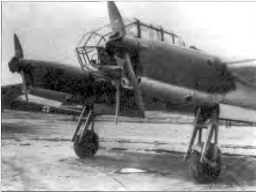
*Ниже кока воздушного винта видно отверстие воздухозборника системы охлаждения двигателя. Два отверстия меньших размеров, расположенные справа и слева от воздухозборника системы охлаждения двигателя, являются воздухозборниками маслорадиатора. Доступ к двигателю облегчался наличием двух больших откидных капотов. На снимке хорошо видно переднее остекление gondoly экипажа.*
