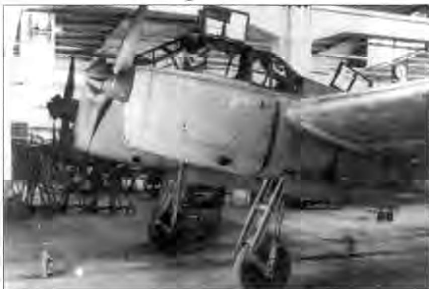
Система охлаждения двигателей серийных самолетов отличалась от аналогичных систем четвертого прототипа Fw-189V-4, на серийных машинах отсутствовали воздухозаборники по бокам мотогондол. На первом прототипе Fw-189V-1 имелись индивидуальные выхлопные патрубки цилиндров мотора, на серийных машинах патрубки объединили общим коллектором.
