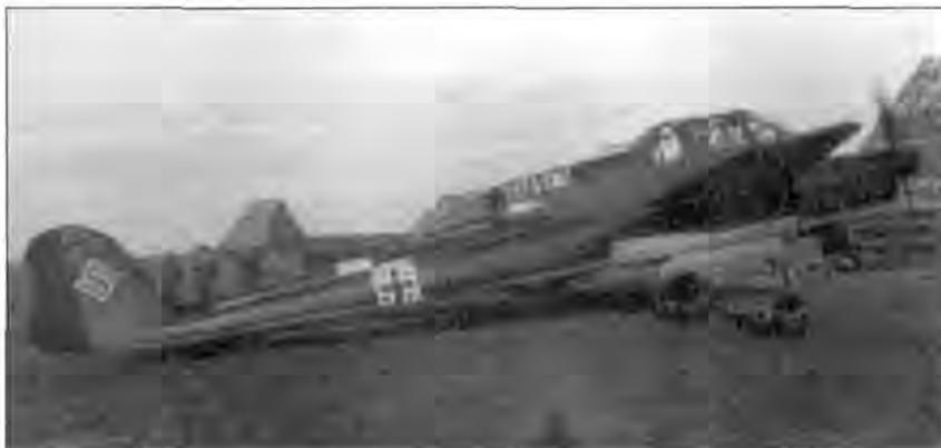
*Интересный снимок Fw-189A. Самолет имеет рули направления, снятые с другой машины, обратите внимание насколько цвет руля высоты отличается от окраски всего планера. По бортовому коду «Т1+СН» можно установить, что разведчик принадлежал подразделению I.(H) 10.*
