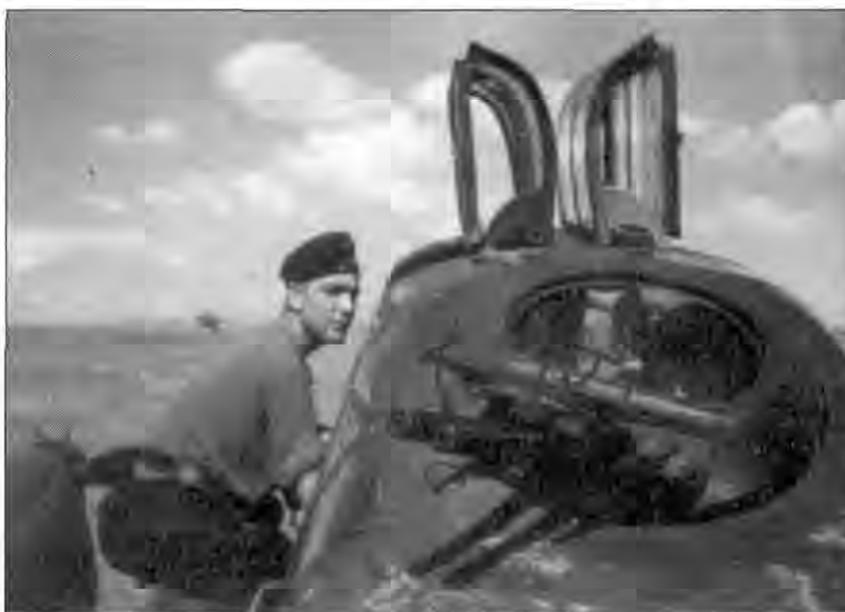
*На поздних Fw-189A-2 монтировалась верхняя турель с остеклением из прозрачной брони и вооружением из спаренного пулемета MG-81Z. Под такое вооружение со временем переоборудовали почти все самолеты Fw-189A-2, действовавшие на Восточном фронте.*
