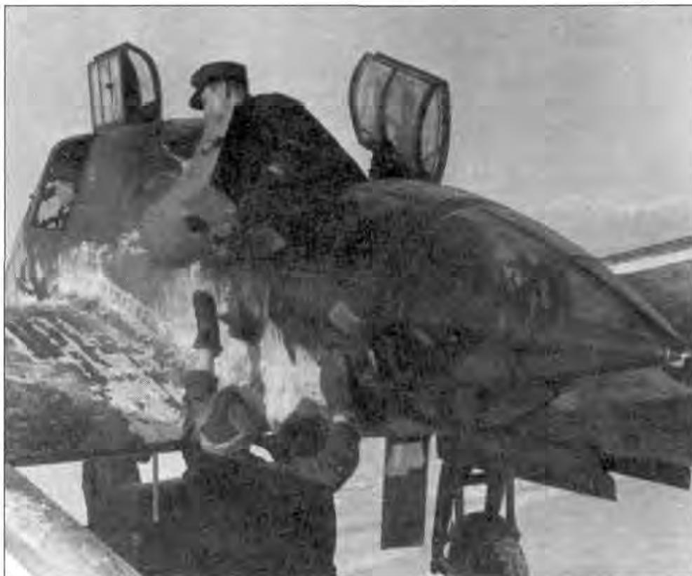
*Полугусеничный бронетранспортер буксирует по снегу разведчик Fw-189 на старт. Под плоскостями крыла видны бомбодержатели ETC-50.*
