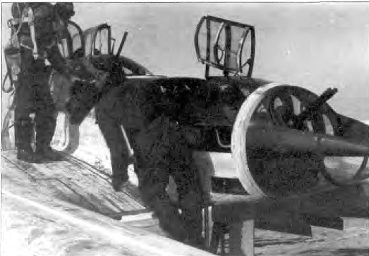
*Экипаж покидает самолет после удачного боевого вылета на Восточном фронте. Обратите внимание на вооружение разведчика. В кормовой установке смонтирован спаренный пулемет MG-81Z, а на верхней турели стоит старый MG-15. Воздушный стрелок кормовой установки пока находится в самолете, его лицо видно через остекление. Все люки для доступа в кабину Fw-189 открывались вверх вбок.*
