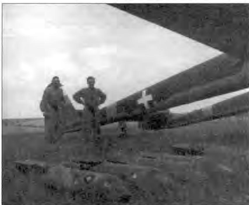
*Два венгерских летчика позируют на фоне своего Fw-189, на переднем плане лежат 50-кг бомбы SC-50. Белые круги на корпусах бомб являются узлами крепления к бомбодержателям ETC-50/VII.*
