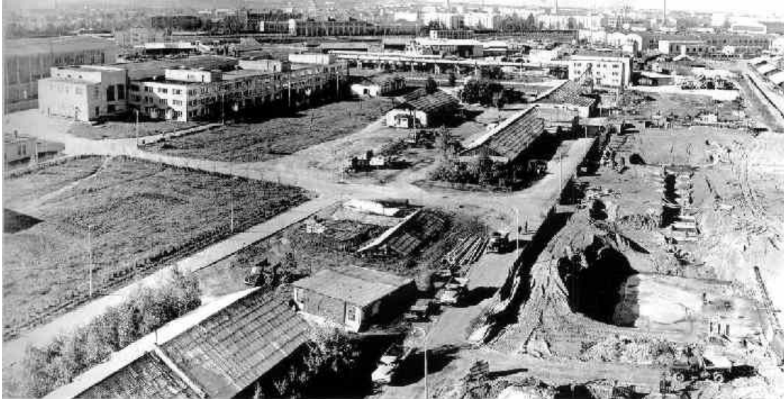
Начало строительства основного производственного корпуса. На снимке слева - лабораторно-конструкторский корпус (1967 г.)
