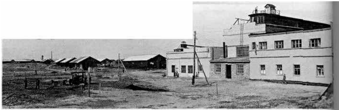
Территория и главный корпус завода (начало 50-х годов)
